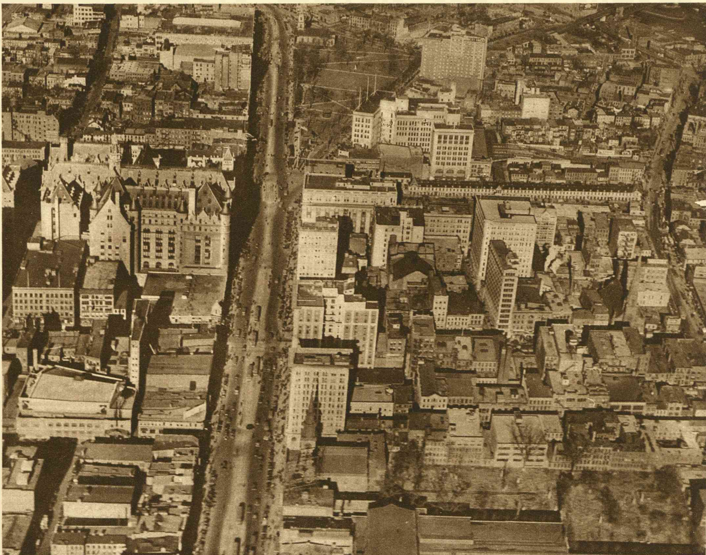
Een zeer interessante luchtfoto van Newark, in den staat New Jersey (U.S.A.). Men schenke vooral aandacht aan de vele verdiepingen hooge gebouwen en het verkeer in de breede straat, ongeveer in het midden der foto.
