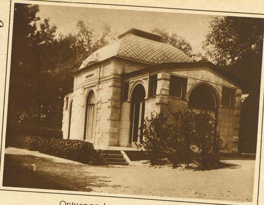
Ontvanggebouw op Westerveld
