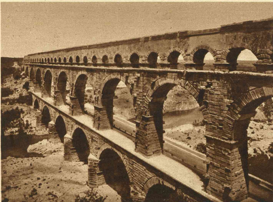
Het oude romeinsche Aquaduct of waterleiding de „Pont du Gard” bij Nimes.
