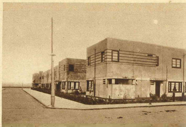
Graanstraat hoek Zaaiersweg.
