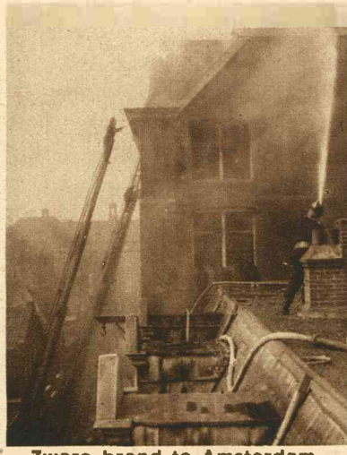
Zware brand te Amsterdam. De vorige week brak in het gebouw „De Phoenix“ in de Passeerderstraat te Amsterdam een zware brand uit. Op onze foto ziet men de brandweer bezig het vuur te bestrijden.
