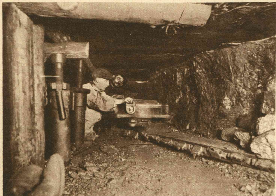
Het aanboren van een steenkoolader. Deze gang is 90 cm. hoog, zoodat de arbeiders voortdurend gehurkt werken moeten.
