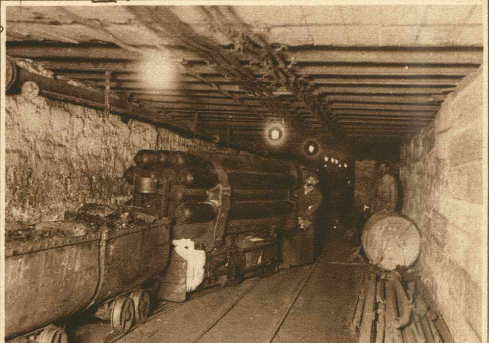
Het kolentransport onder den grond vindt plaats door middel van kipkarren, die door een benzine-locomotief worden voortbewogen.
