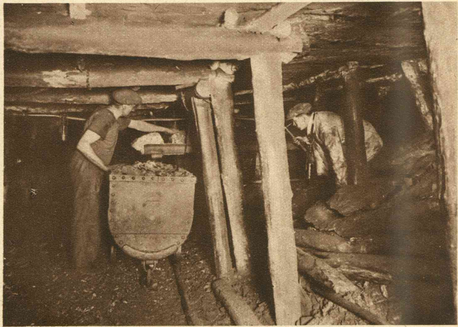
Het uitwerpen der gevonden steenen. Deze foto doet vooral het zware stutwerk goed uitkomen.
