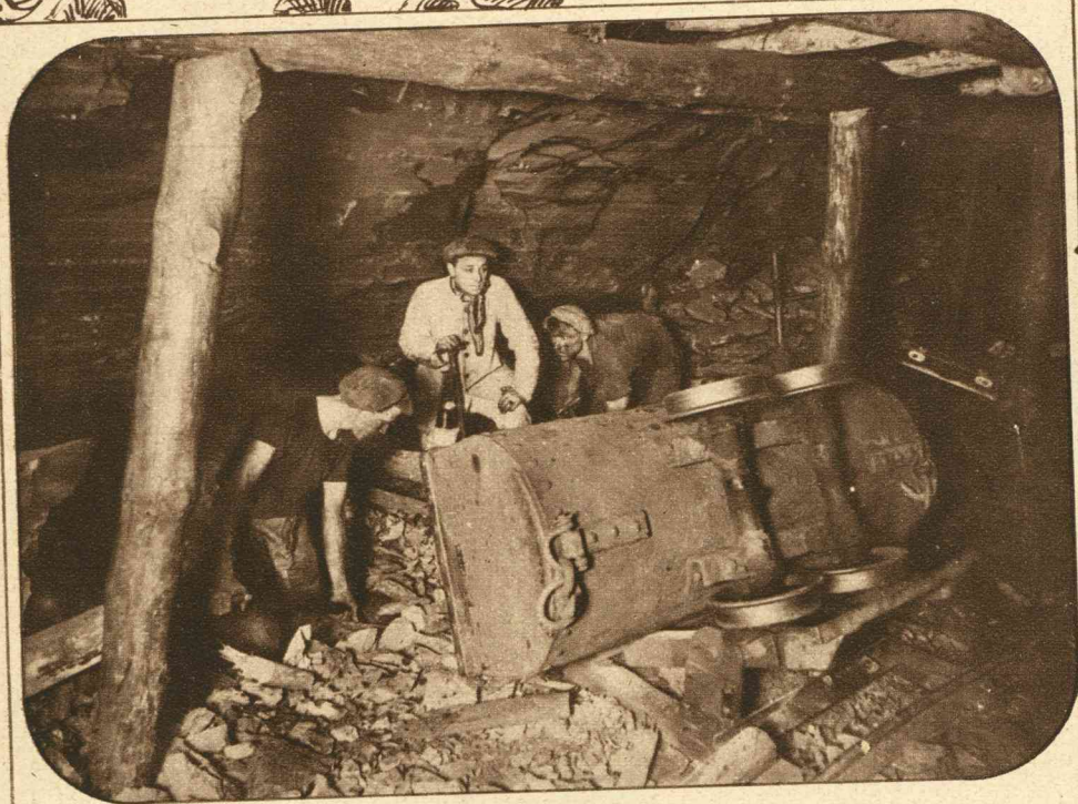
De steenen, die niet gebruikt kunnen worden, bezigt men als steunmateriaal. De gaten, ontstaan door het uithalen der steenkool, vult men ook op met deze steenen.
