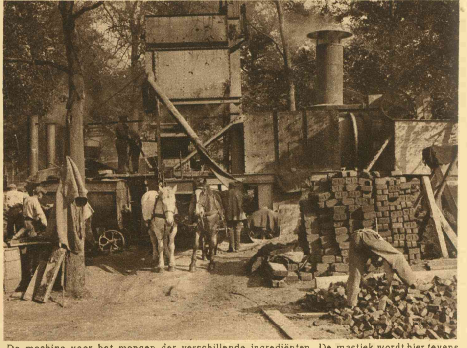
De machine voor het mengen der verschillende ingrediënten. De mastiek wordt hier tevens op een enorme hitte gebracht.
