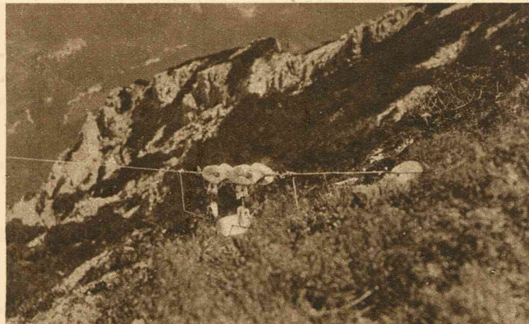
En station voor draadlooze telegrafie zonder masten te Walchensee. De verankerde antenne met isolatoren, aan den top van den „Herzogenstand”.
