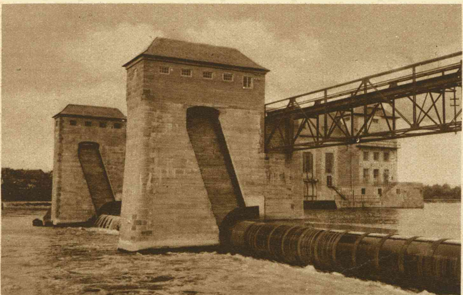
Het stuwwerk bij Main-Aschaff (Aschaffenburg). Het winnen der electriciteit als drijfkracht voor de sluisen.
