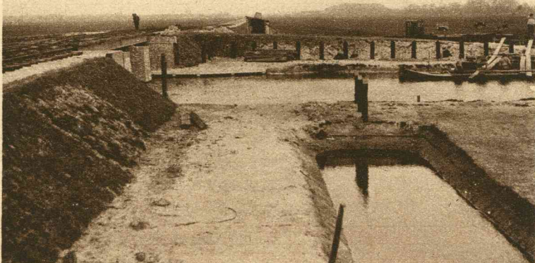
Links : De overbrugging van de Korte Vliet.
