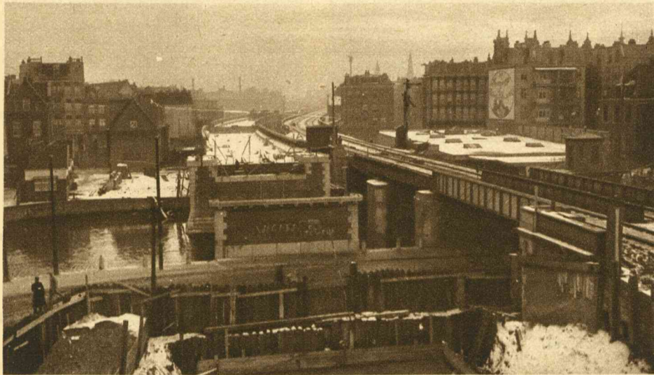
De viaducten aan de Houtmankade. Rechts het oude viaduct. Links het in aanbouw zijnde nieuwe viaduct.
