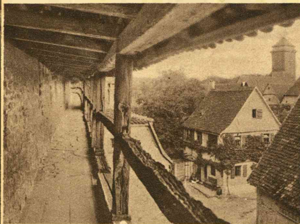
De overdekte verdedigingsgang, die zich op ongeveer 20 meter hoogte op den de stad in het Noorden en Oosten begrenzenden muur uitstrekt.
