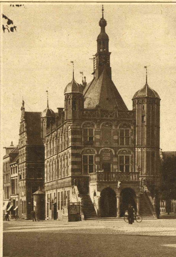
Het fraaie Waaggebouw, dat op de Markt staat. De voor-gevel is, jammèr genoeg, links aan het verzakken. Op onze foto ziet men duidelijk de schutting, die men er omheen gezet heeft.
