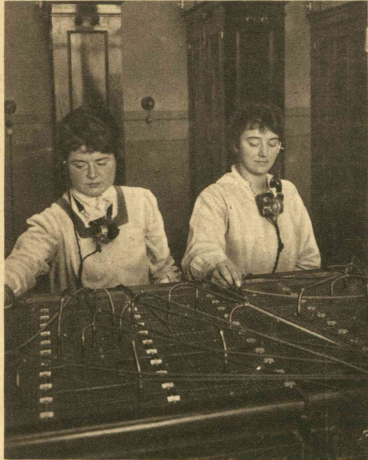
Telefonisten aan het werk in een centrale met handsysteem, waarbij de telefoon-verbindingen met snoeren worden tot stand gebracht.
