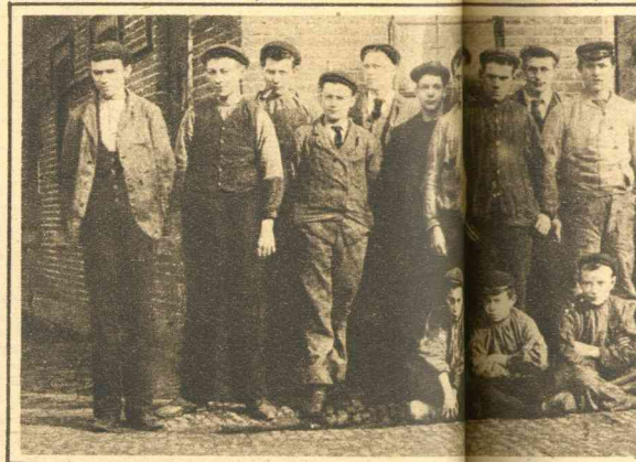
Het personeel bij de oprichting van de apparatenfabriek.
