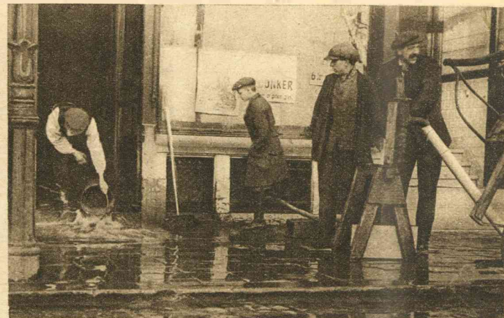
De gevolgen van het springen eener waterleiding bij ingetreden dooi: Het ondergelopen huis wordt leeggepompt en leeggehoosd.
