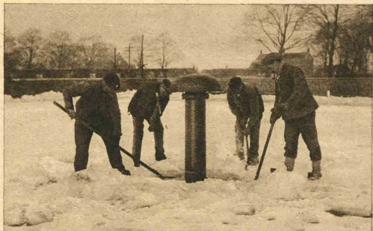
De luchtbuizen in de filterbassins der gemeente-waterleiding moeten voortdurend worden vrijgehouden.
