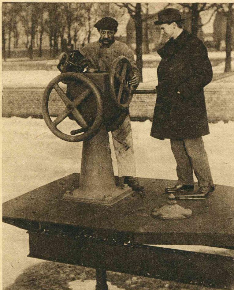
Het waterstands-controletoestel der gemeente-watervoorziening moet telkens weer ontdooid worden.
