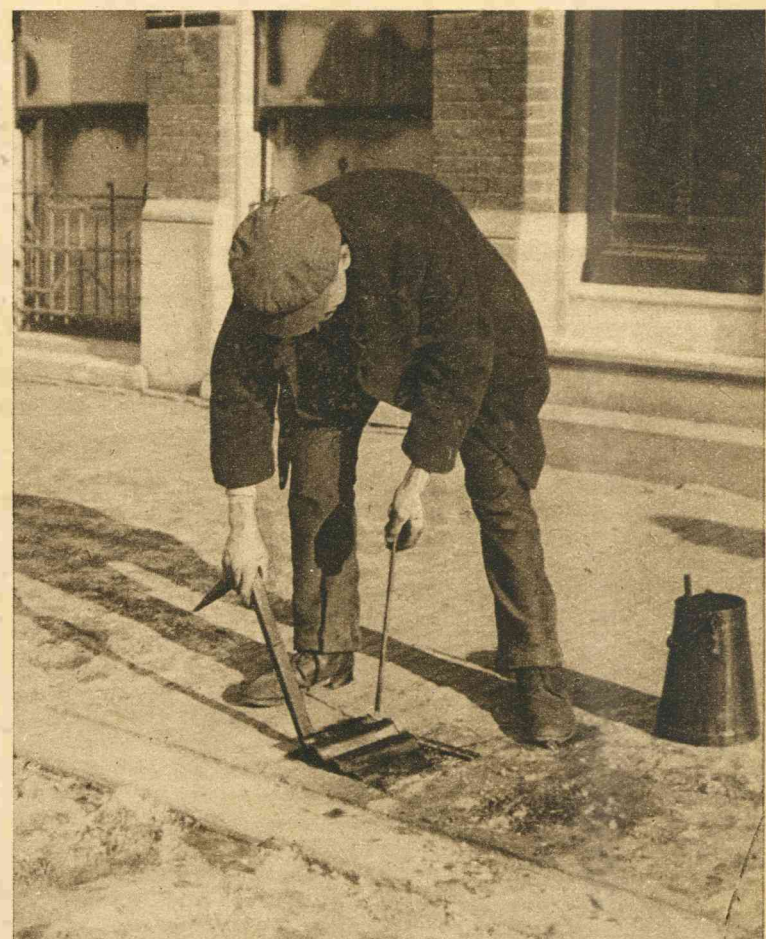
De honderden brandkranen in de steden worden geregeld in de olie gezet en ontdooid.
