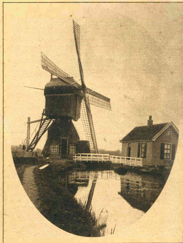
Oudhollandsch watermolentje bij den Angstel. Door middel van een groot scheprad wordt het water uit den polder gebracht.
