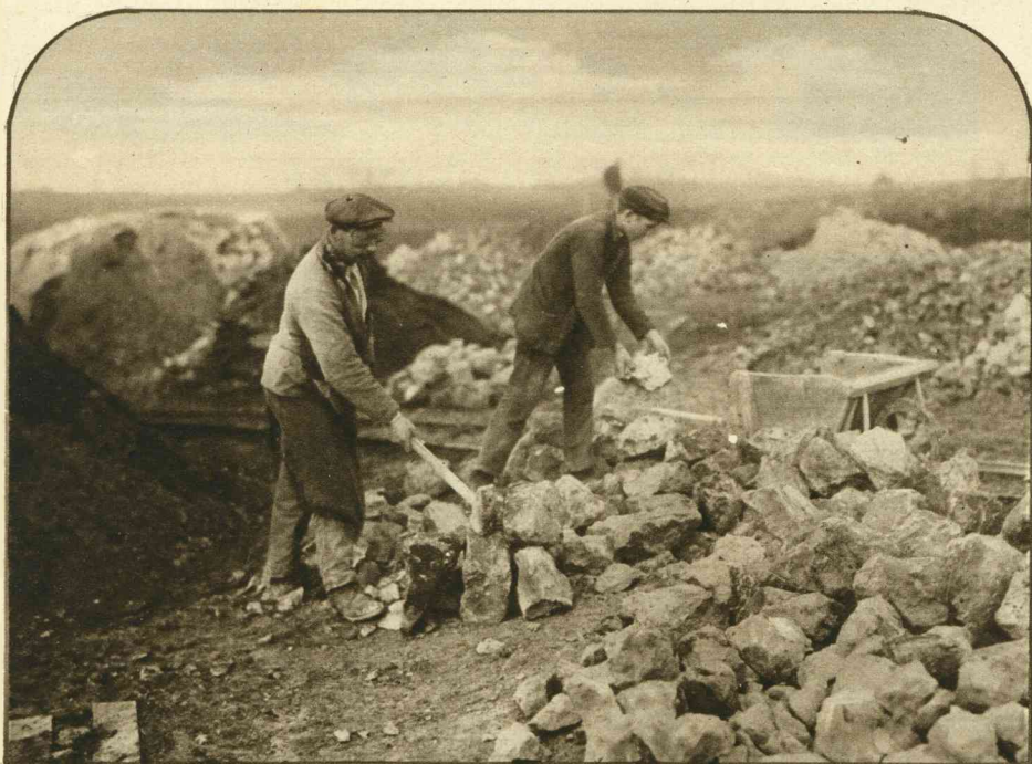
De steenen worden na te zijn losgewerkt nog in stukken gekapt alvorens naar de ovens vervoerd te worden.
