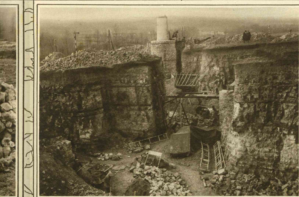
Het in aanbouw zijnde ovensysteem, bestaande uit dubbele ovens met circuleerende trek. Rechts de uitgraving voor de fundeering der fabriek voor prepareering van kalkmergel, ten dienste van den landbouw.
