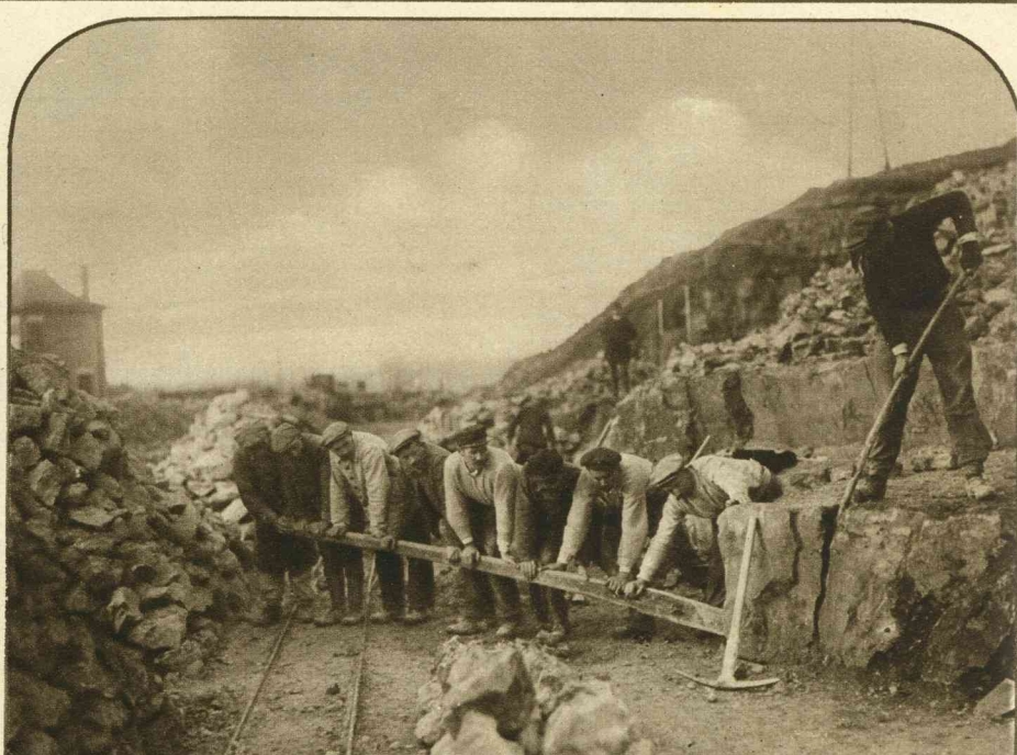
Het loswerken der groote steenblokken, hetgeen zooals men ziet, een zwaar werkje is.
