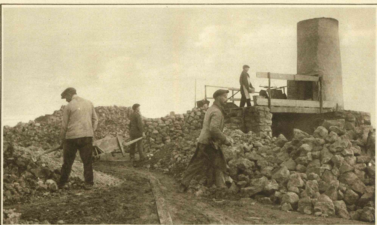
Een voor dit bedrijf speciaal gebouwde oven met buitenvuren, ter verkrijging van zuiverder product, dan bij het gewone veldovensysteem het geval is.
