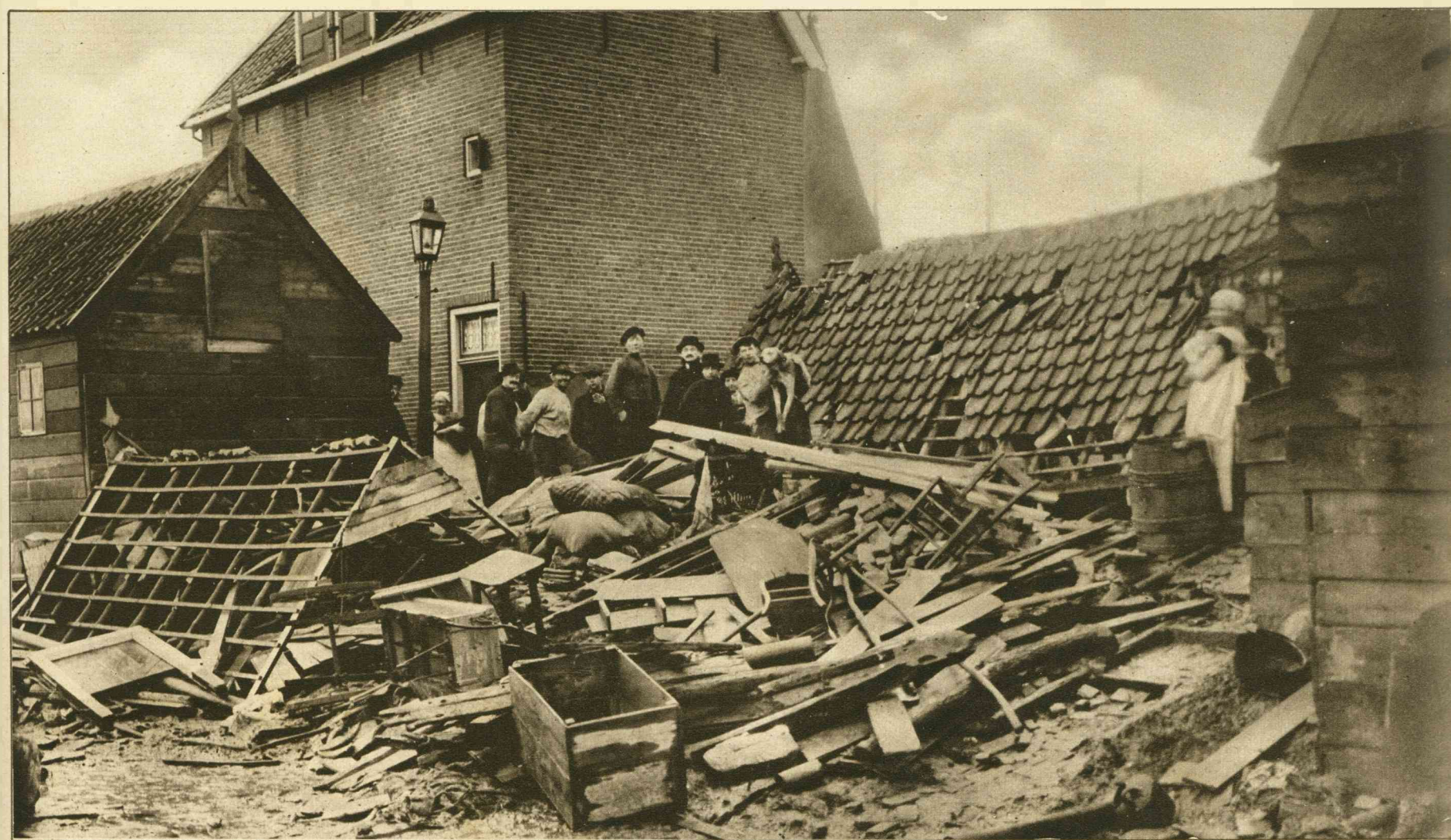
Boven: een rij Spakenburgsche huisjes, die door wind en water enorm hebben geleden en nog steeds in het water staan. Beneden: De overblijfselen van een huisje, waartegen aanhoudend losgeslagen bollers aanbeukten.
