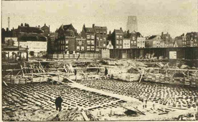
De enorme massa palen (totaal 8500, elk van 14—20 M. lengte) die het stadhuis moeten dragen.
