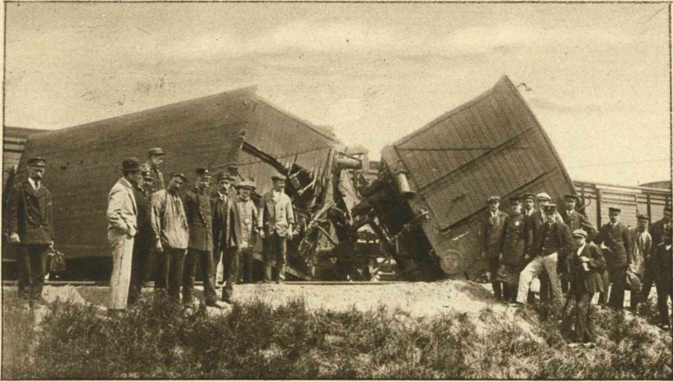
SPOORWEGDERAILLEMENT. Nabij Rotterdam ontspoorde Donderdagochtend een goederentrein. Persoonlijke ongelukken hadden niet plaats, doch de materiele schade is tamelijk groot. De wagens waren in elkander gewerkt en op de foto ziet men duidelijk de afgekapte buffers. Het personenvervoer ondervond eenige vertraging.
