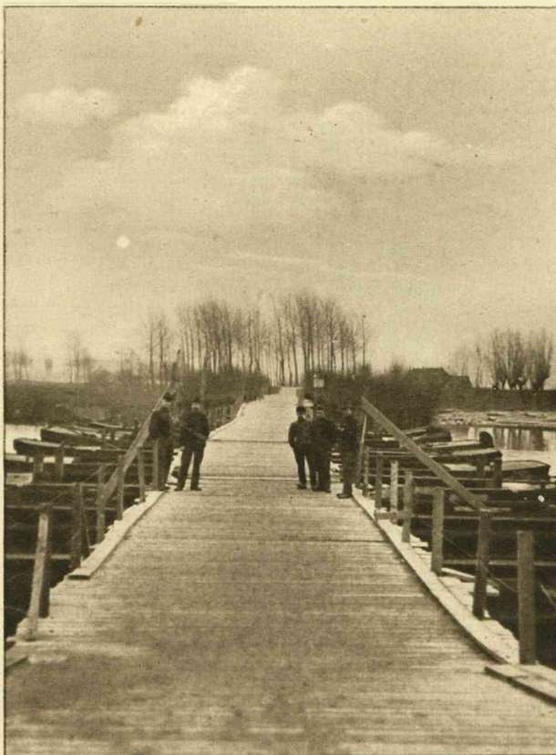
EEN KRANIG STUK WERK. Een schipbrug van 170 M. lengte geslagen over de rivier de Linge.
