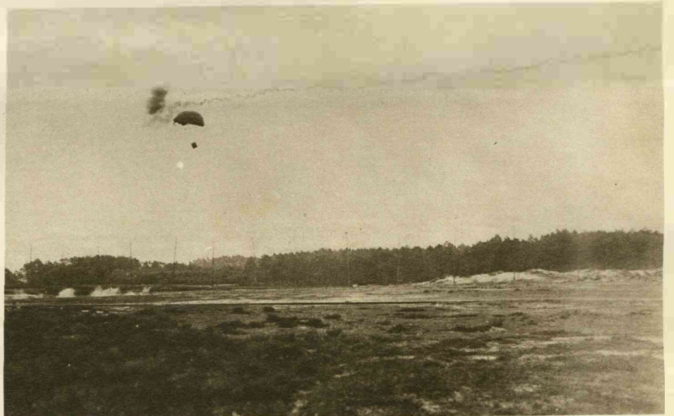
Foto No. 5. DE BAAN, DIE HET PROJECTIEL DOORLOOPT, DOOR EEN ROOKSTREEP ZICHTBAAR GEMAAKT.
