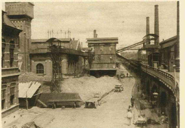
Gezicht op het terrein der Gasfabriek aan den Oostzeedijk. Links ziet men nog het administratiegebouw en den toren van de Watergasfabriek; rechts de viaduct. Geheel in de verte is het terrein der gashouders.
