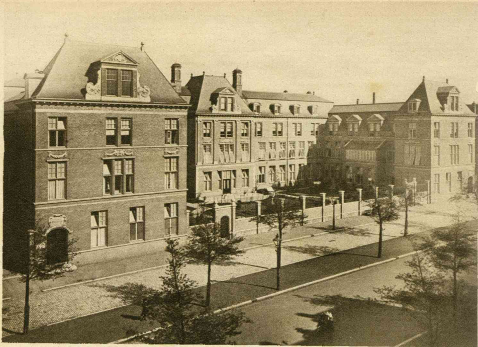
HET PAS GEOPENDE FRAAIE GEBOUW.
