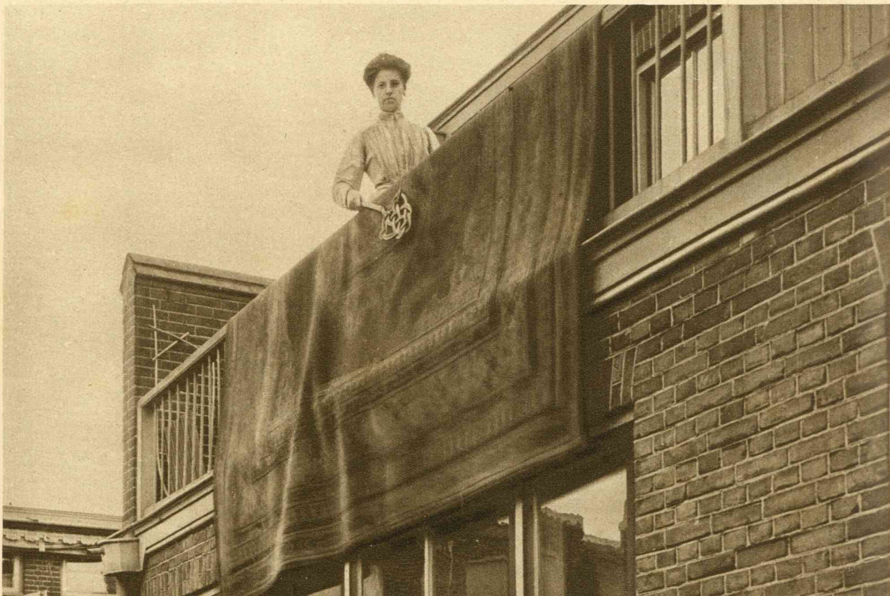
Kleedenkloppen op dak.
